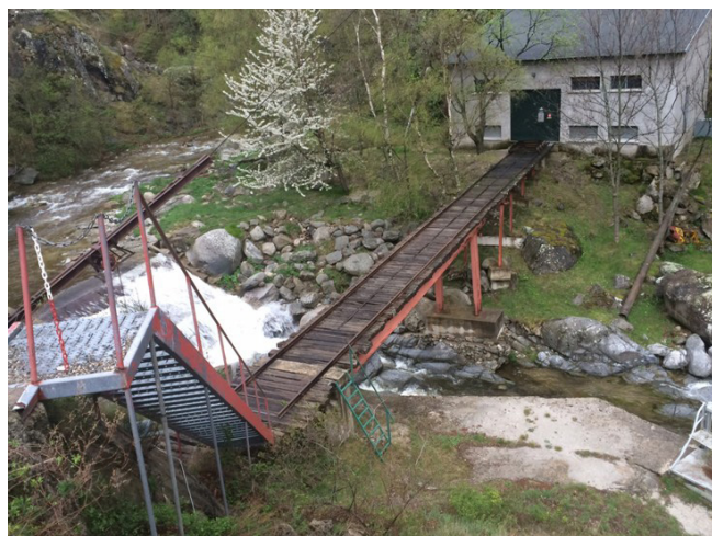
Installation hydroélectrique à Sahorre sur la Rotja
